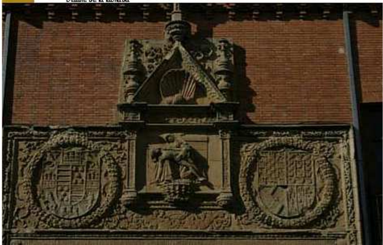
Detalle de la fachada
